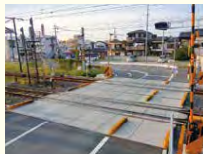
接続軌道・路盤の不陸整正
