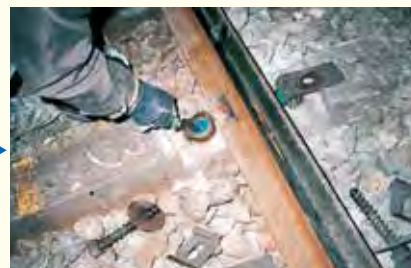
穿孔部へ埋込栓をセット
