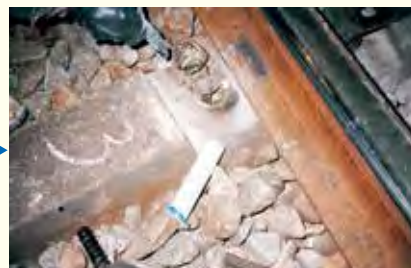
穿孔部へVE-1塗布後、VE-2を投入
