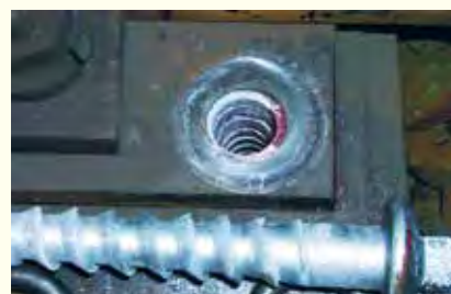
ケミカルアンカーによるねじ山再生状態
