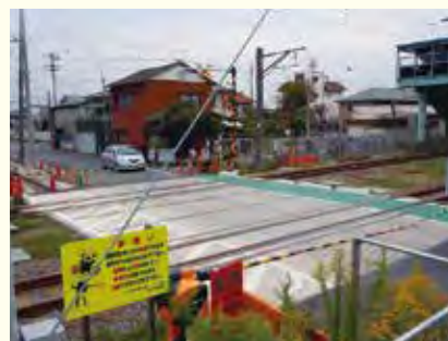
接続軌道・路盤の不陸整正
